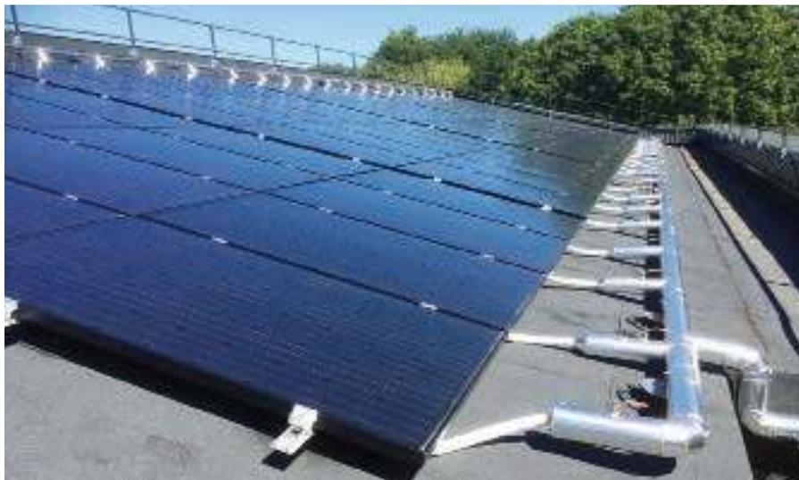
Les toitures sont couvertes d'un champ de 1 037 m<sup>2</sup> de panneaux hybrides.
