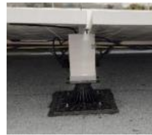
Mise à la terre réhausse 200 aluminium sur système Soprasolar Fix Evo TILT par clip Rayvolt®
