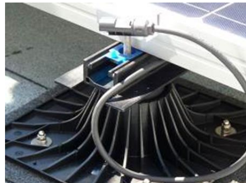
Figure 17 : Orientation de la tête du plot pour la pose du module photovoltaïque
