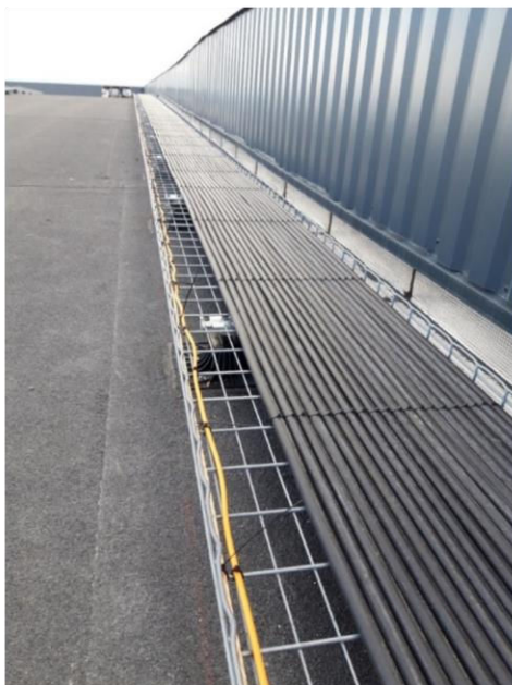
Figure 15 : Supports de chemin de câble par oméga ou plots SOPRASOLAR FIX EVO
