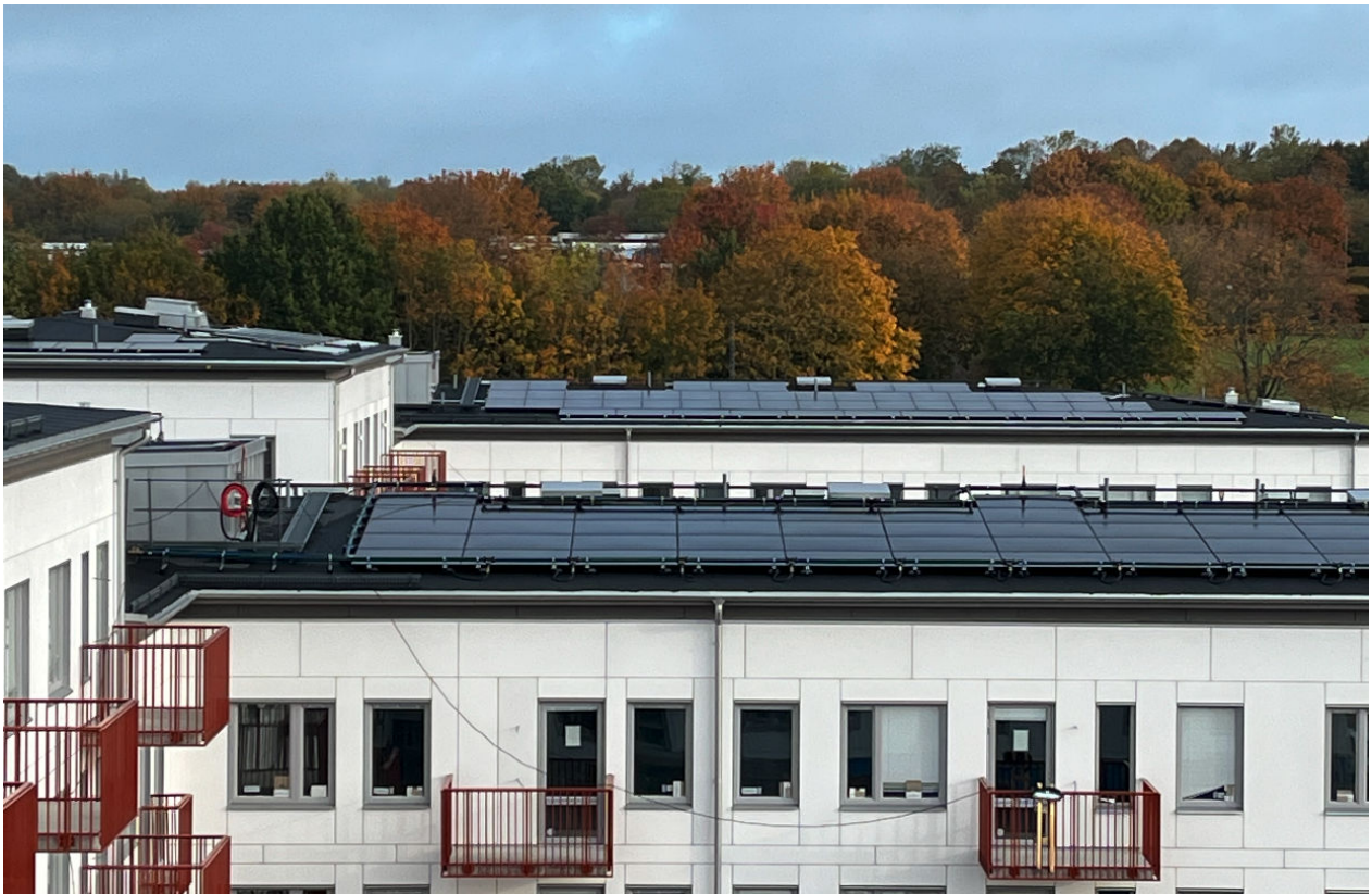
Immeuble Magnolia à Lund en Suède où le système énergétique PV-T + pompe à chaleur géothermique conçu par Kraftringen permet de réduire l'empreinte carbone obtenue avec le seul chauffage urbain. Cette installation solaire DualSun combine 168 panneaux PV-T et 150 panneaux PV.
